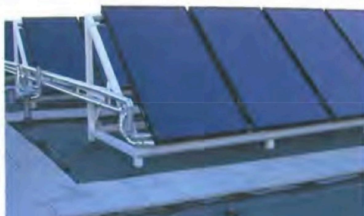
да бъде използвана и като втори енергийен източник към съществуващата отопителна система. Над 60% от годишните нужди за топла вода могат да бъдат осигурени чрез соларна система на De Dietrich.
